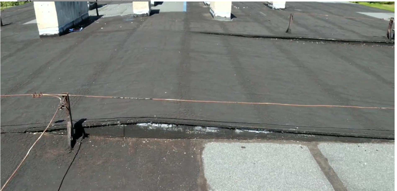
Zdjęcie nr 11 – Różnica poziomów dachu
