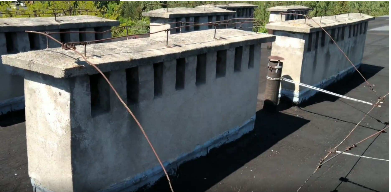
Zdjęcie nr 5 – Komin murowany
