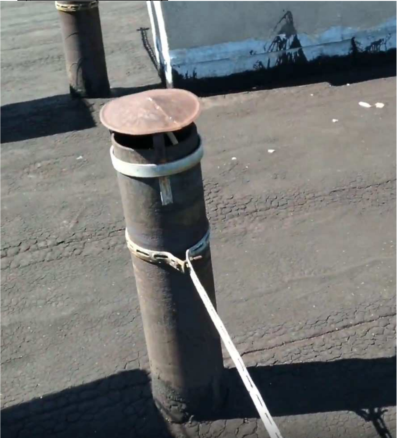
Zdjęcie nr 7 – Kominiek pionu kanalizacyjnego
