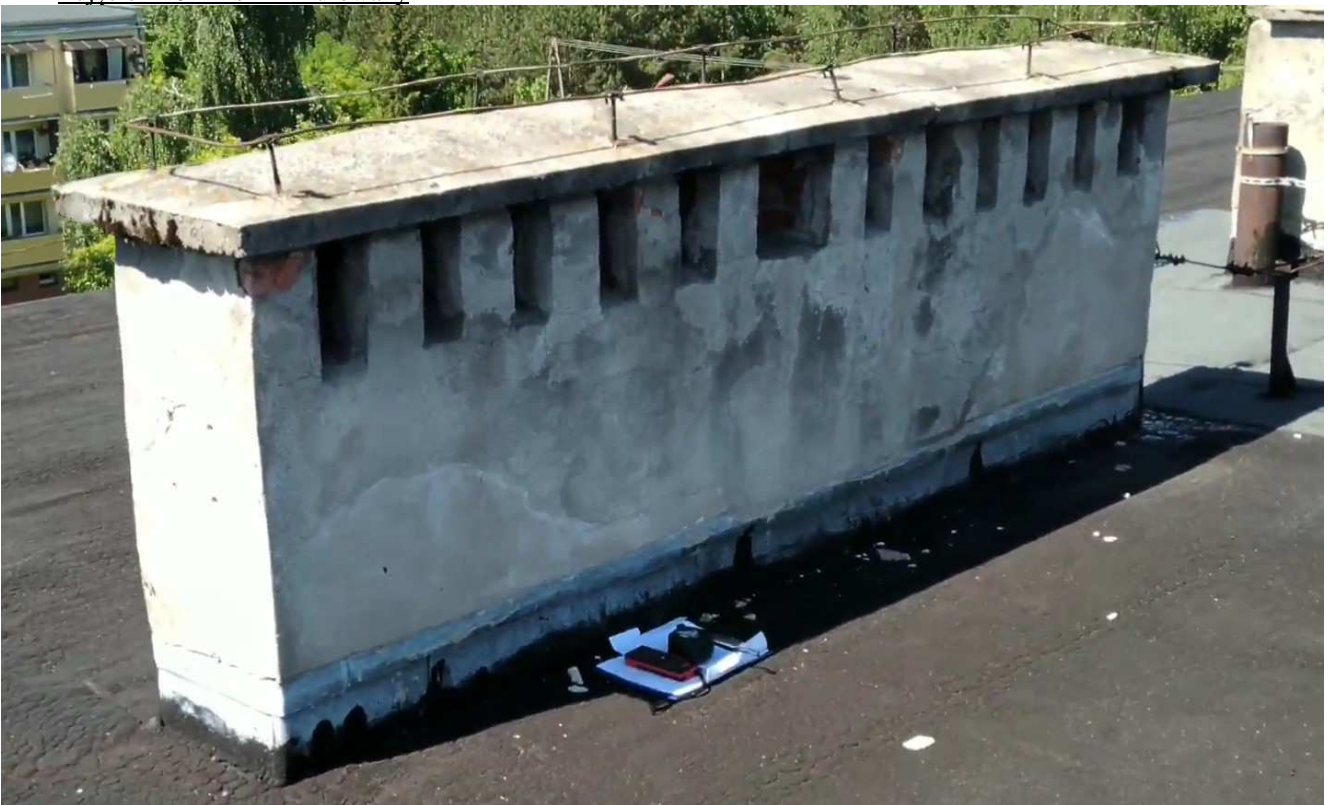
Zdjęcie nr 6 – Komin murowany
