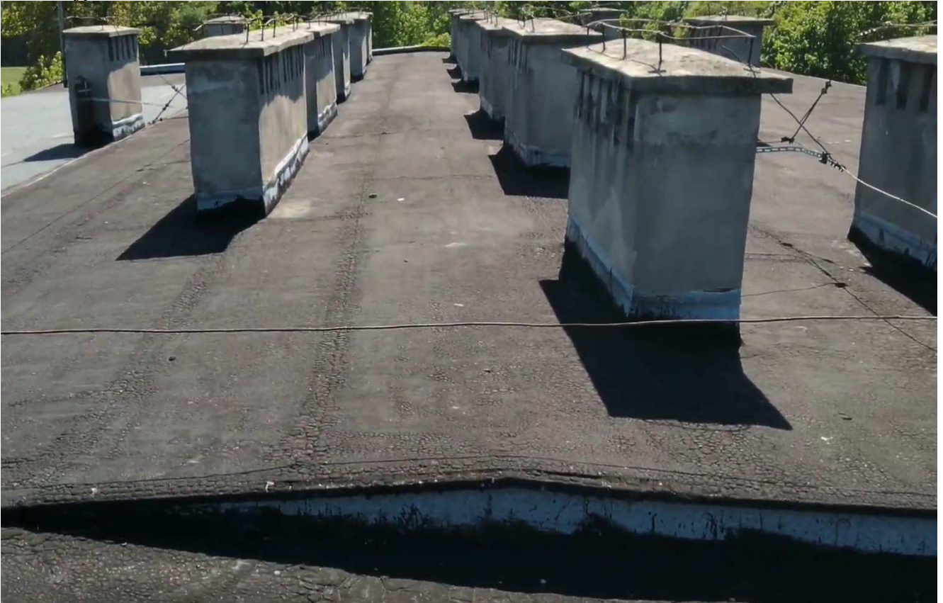
Zdjęcie nr 2 - Widok dachu
