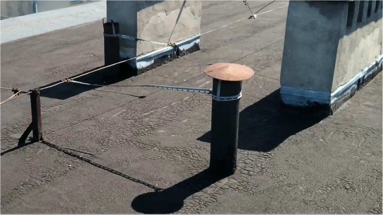
Zdjęcie nr 14 – Kominiec pionu kanalizacyjnego
