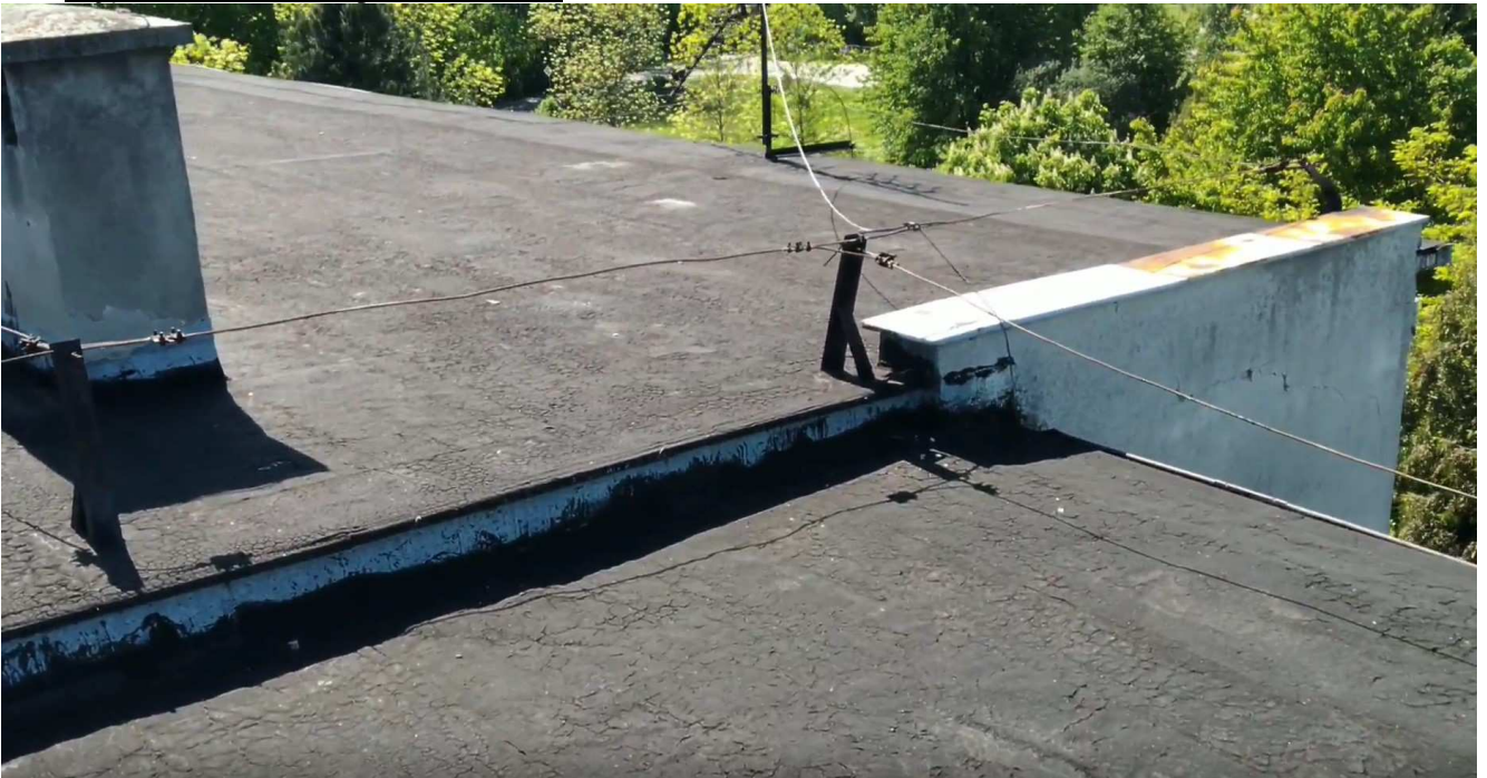
Zdjęcie nr 12 – Różnica poziomów dachu
