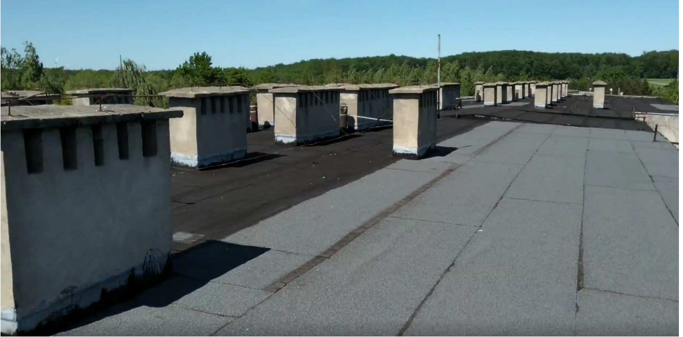
Zdjęcie nr 1 - Widok dachu
